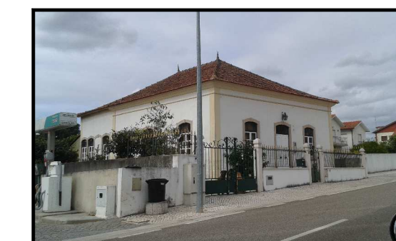
Razoável Estado de Conservação
