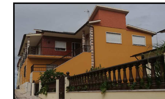
Bom Estado de Conservação
