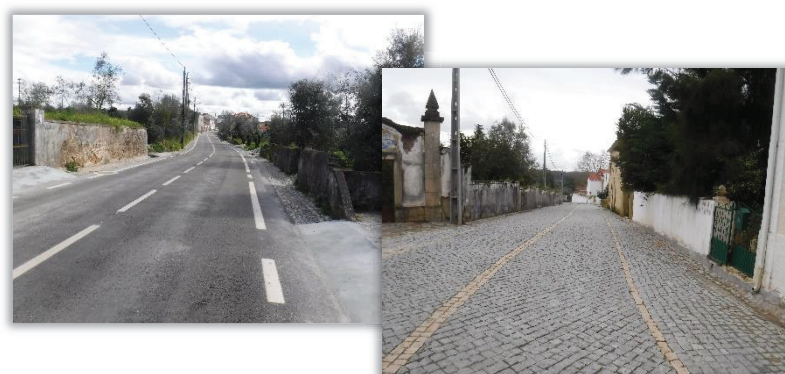
Figura 9 - Rua Visconde de Souzel (EM517 - Cavadas a Pussos)
