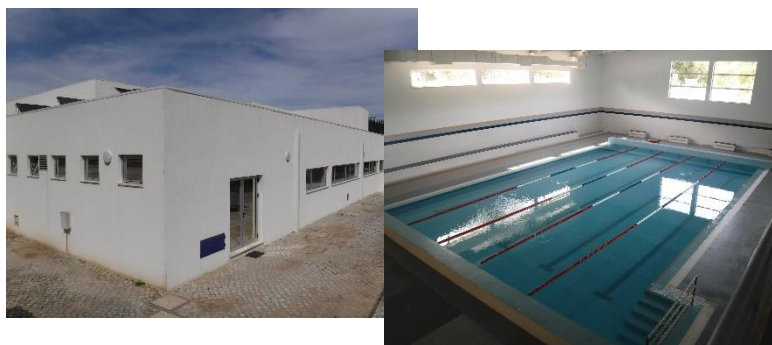
Figura 7 - Beneficiação e melhoria da eficiência energética no edifício das Piscinas Cobertas
