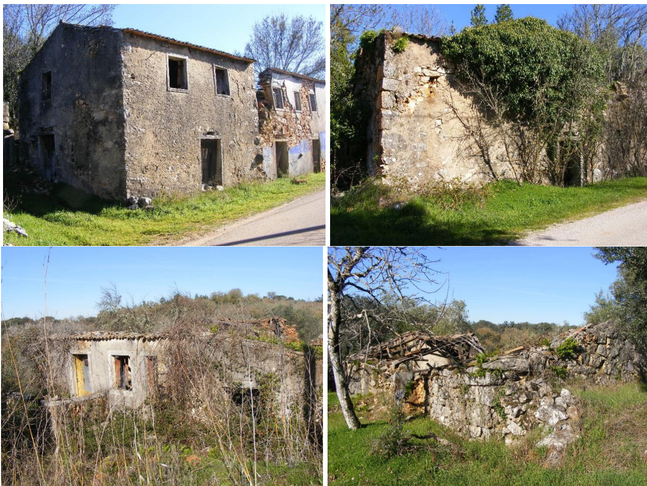
Figura 8: Edificado em ruína na ARU
