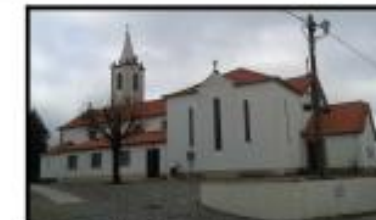
Bom Estado de Conservação
