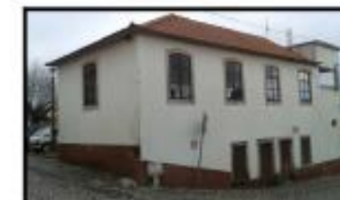
Razoável Estado de Conservação
