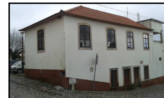
Razoável Estado de Conservação
