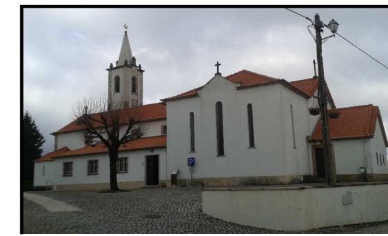
Bom Estado de Conservação
