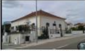
Razoável Estado de Conservação
