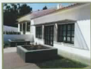
Figura 22 - Empreitada de Remodelação da Escola Primária do Barqueiro - Centros de Interpretação - Mini Unidades de Alojamento
