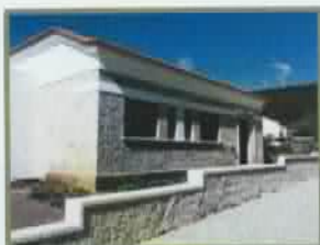
Figura 25 - Empreitada de Remodelação da Escola Primária do Bofinho - Centros de Interpretação - Mini Unidades de Alojamento
