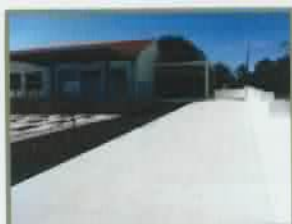
Figura 24 - Empreitada de Remodelação da Escola Primária de Venda do Preto - Centros de Interpretação - Mini Unidades de Alojamento
