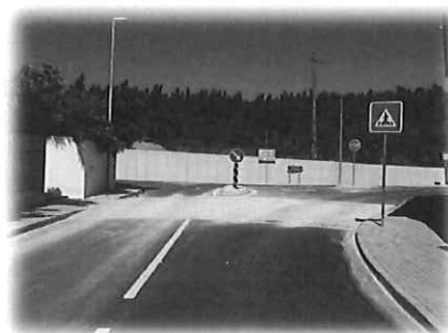
Figura 7 - Rua Sra. da Orada, sita em Cabaços freguesia de Pussos S. Pedro
