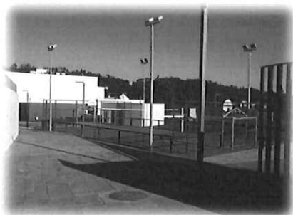
Figura 1 - Centro Escolar de Alvaiázere
