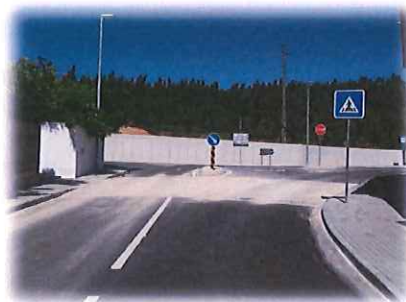
Figura 7 - Rua Sra. da Orada, sita em Cabaços freguesia de Pussos S. Pedro
